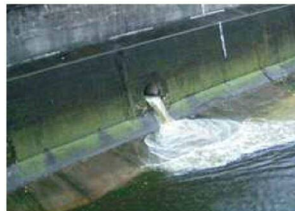
雨水吐からの放流状況
